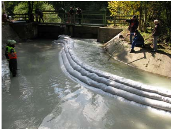
Abb. 17: Stabile 10er Barriere bei bordvollem Abfluss.
