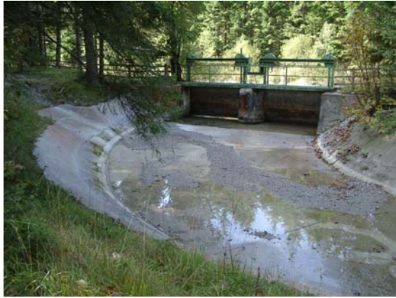
Abb. 2: Schützwehr und Kanal im Kurveneingang.
