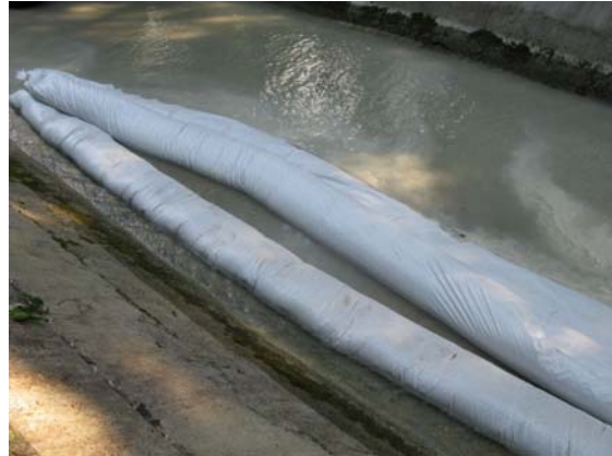
Abb. 10: Beschädigte 3er Barriere in der Gerade nach Abflussreduzierung.
