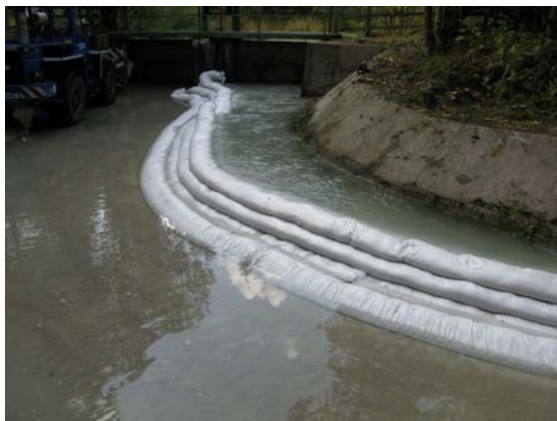
Abb. 15: Stabile 7er Barriere bei bordvollem Abfluss.
