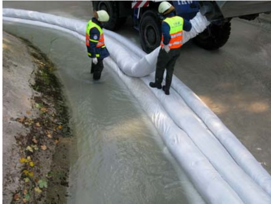
Abb. 13: Verlegen des obersten Schlauchs der 7er Barriere.
