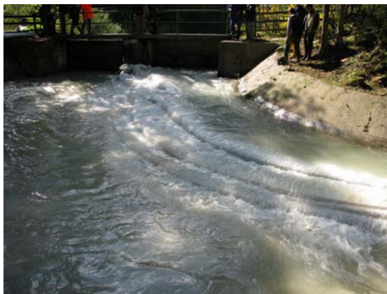
Abb. 21: 10er Barriere im Endzustand nach dem Versagen.
