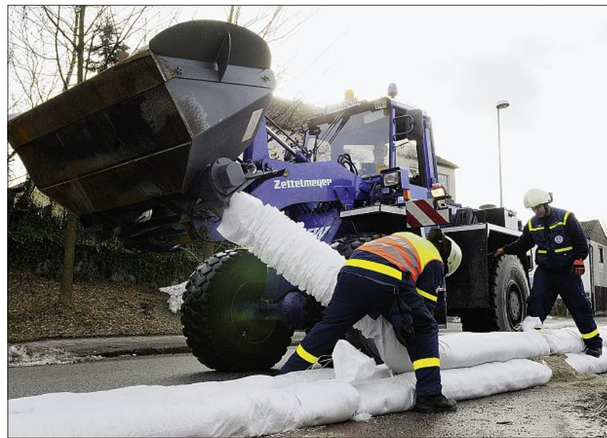
Ein Mann genügt, um die Rohre mit Folie von einer 750-Meter zu bestücken. – Drei Mann braucht man für das Verlegen: Einer fährt, einer weist ein, der andere schaut, dass die Schläuche auch richtig in Pyramidenbauweise liegen.
